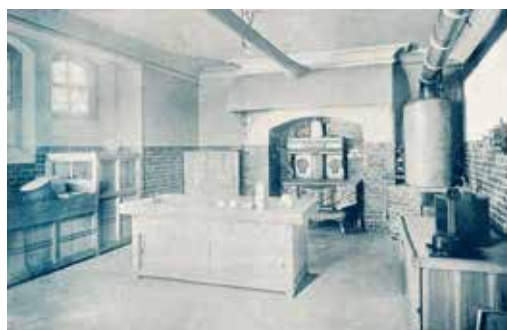
26-1 「厨房」(竣工アルバム)
