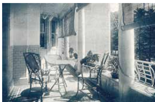
20-1 「開廊」(竣工アルバム)
