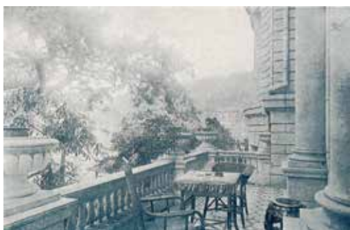
19-1 「露臺」(竣工アルバム)
