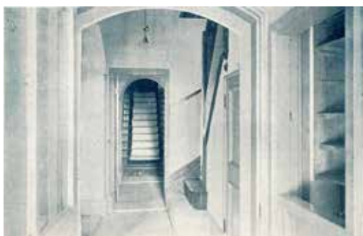
26-2 「階下室」(竣工アルバム)
