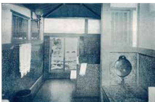
24-3 「四階浴室」(竣工アルバム)
