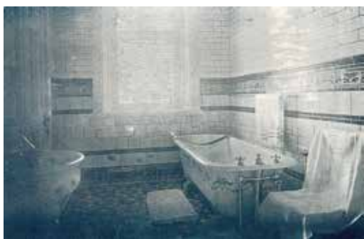
13-1 「東浴室」 竣工アルバム
