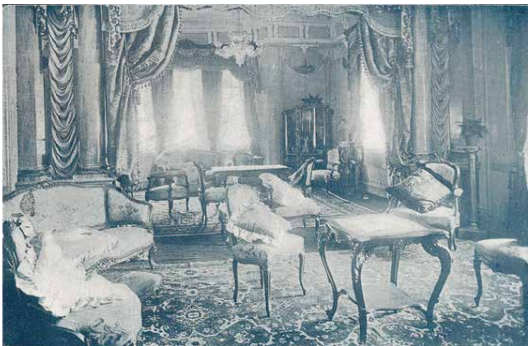
3-1 「客間」(竣工アルバム)
