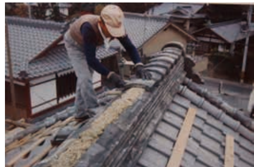
写真10 資料館屋根葺
