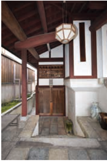
写真11 半地下階入口
