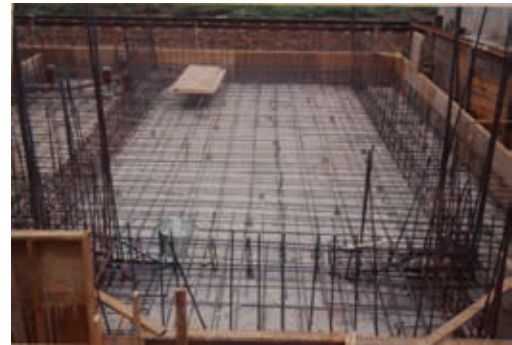
写真8 資料館基礎工事
