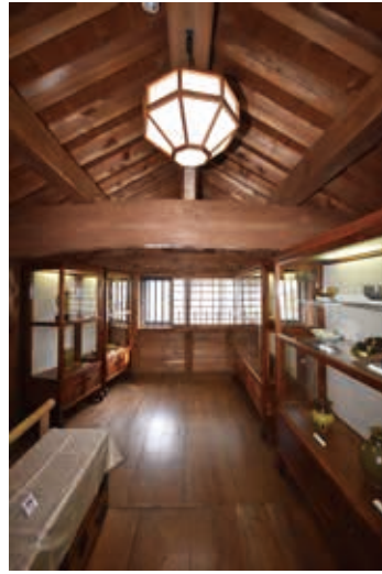
写真12 2階資料収蔵室（現展示室）
