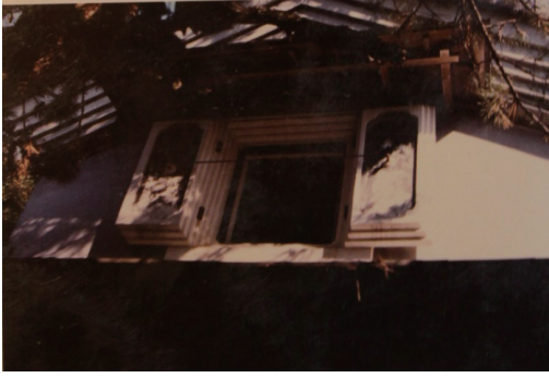
写真4 移築前土蔵2階窓
