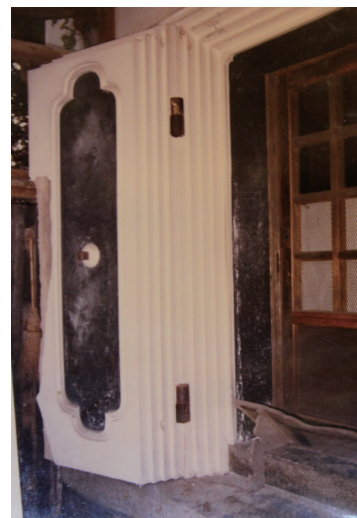
写真3 移築前土蔵扉
