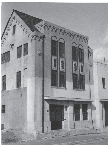
写真7 曳家工事完了後の辻商店旧建物
