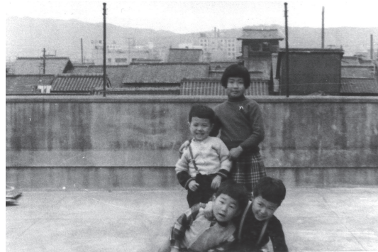
写真14 屋上テラス, 西をみる
