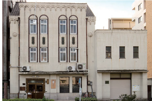
写真2 建物東面，2016年撮影
