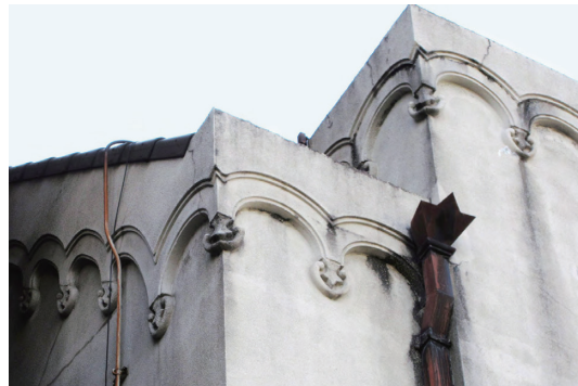
写真4 南東隅部，ロンバルディア帯と縦樋
