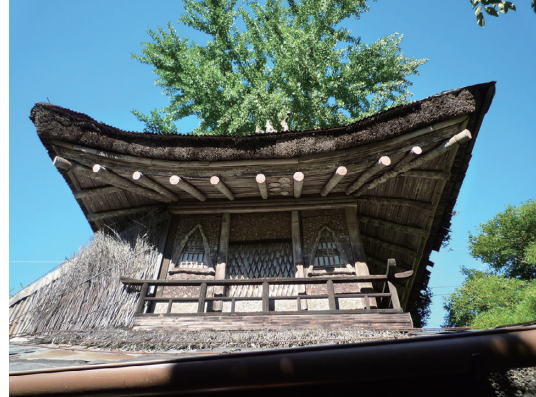
写真14 御殿 2層目外観西面
