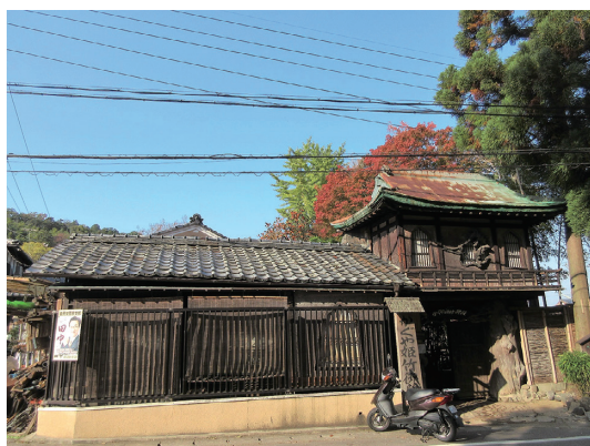
写真2 楼門と付属棟（平屋棟）
