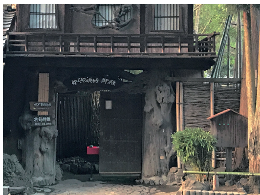
写真4 楼門 外観南面1階
