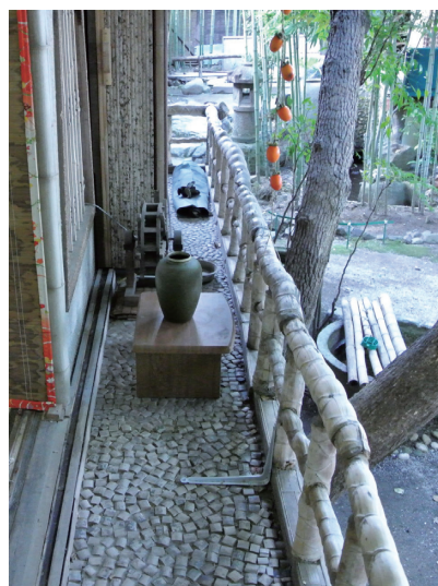
写真9 客殿 濡縁、高欄
