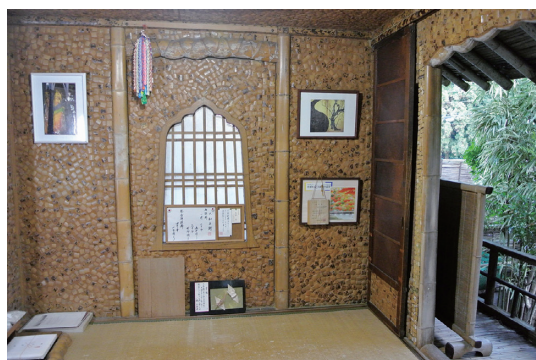
写真18 御殿 1層目内部東面
