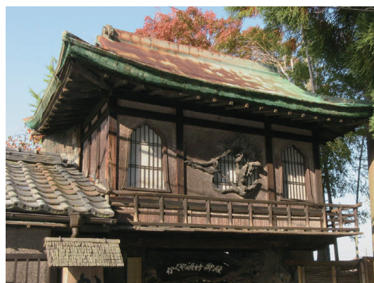
写真3 楼門 外観南面2階
