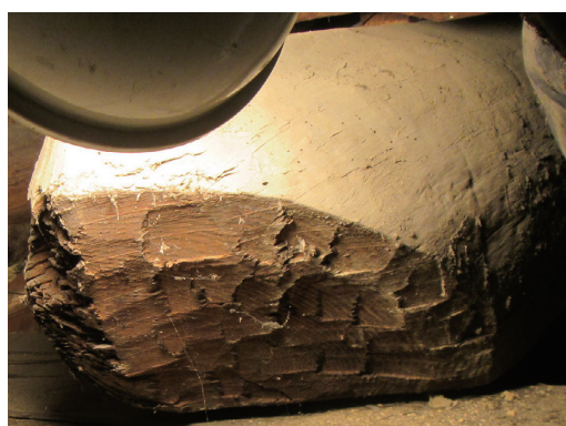
図10 内陣棟と外陣棟を繋ぐ桁材
